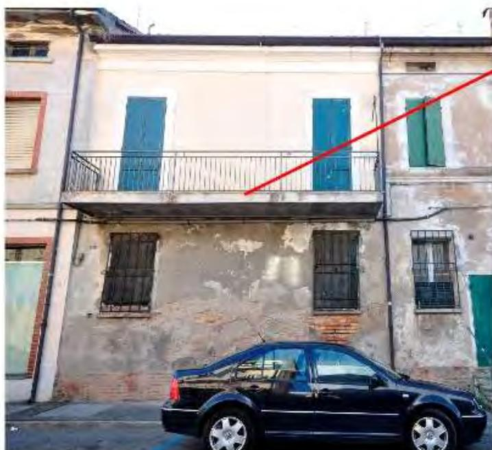
Demolire il balcone sul fronte e ripristinare la dimensione originaria delle due finestre. Tale intervento dovrà essere attuato nel momento in cui si interverrà sulla facciata.
