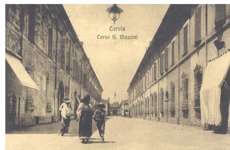
Foto 55 - Corso Mazzini (1912 circa) lato sud in una cartolina del fondo iconografico G. Luciani. Anche in questa foto le fronti risultavano integre, il lato sinistro si è maggiormente conservato, in particolare negli allineamenti orizzontali, mentre il prospetto di destra sarà oggetto di alcune modifiche (sostituzione dell'unità n. 92 e sopraelevazione della 91 - Direzione saline).
