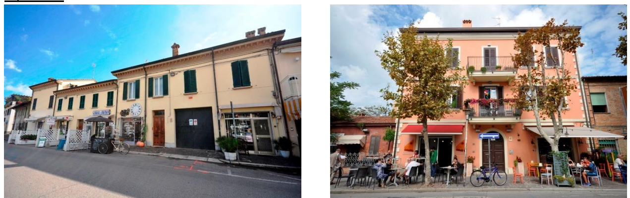
Foto 65 e 66 - Edifici in Borgo Marina riconducibili ai tipi D.5 e D.6 (foto A. Vallicelli)
