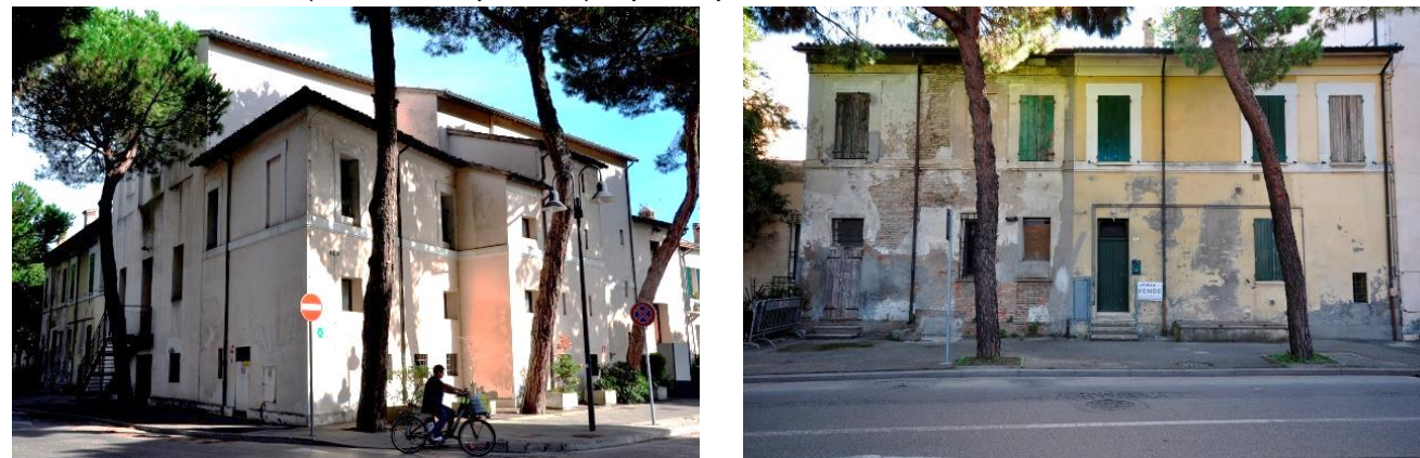
Foto 29 e 30 - a sx il nuovo teatro (tipo A.s2), a dx la parte di baluardo, ora residenza, che conserva ancora gran parte dei caratteri originari (foto A. Vallicelli)
