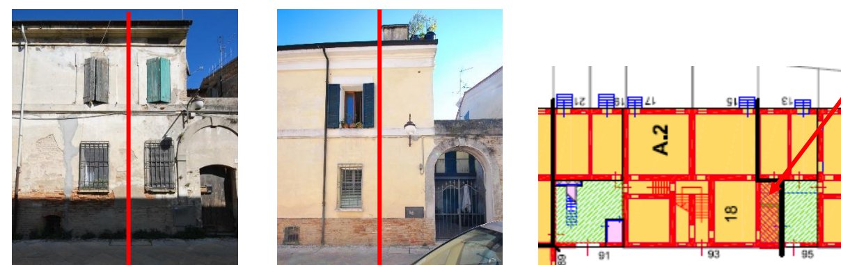
Foto 76, 77 e stralcio tav. CS.2a (Unità n.18) – Case dei Salinari, incrementi laterali di una cellula contratta su due piani ad intasamento del cortile. Nel primo prospetto (Unità n. 13) vengono inserite due aperture (pt e p1) allineate a quelle esistenti, nel secondo prospetto (Unità n. 18) le finestre sono interne al cortile. Si noti il muro dell'area di pertinenza "sovrastato" dall'ampliamento che comunque presenta caratteri di continuità ed organicità con l'organismo originario.
