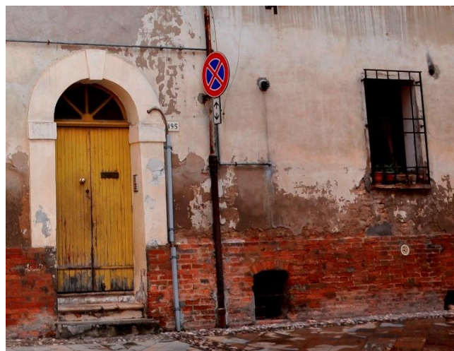
Foto 12 e 13 - il basamento con le bocche di lupo dell'interrato e il portale sagomato, il marca davanzale a sezione circolare in tavole intonacate (foto A. Vallicelli)
