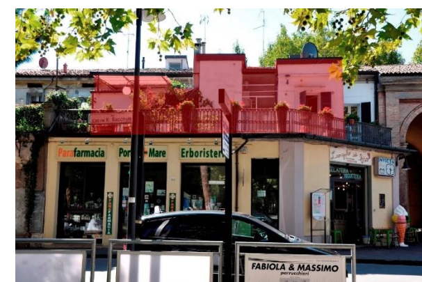
Foto 83 e 84 – Incrementi orizzontali e verticali fuori sagoma nelle Unità n.12 e n.9 (Case dei salinari). Nella foto a sx ampliamento incongruo per materiali e
