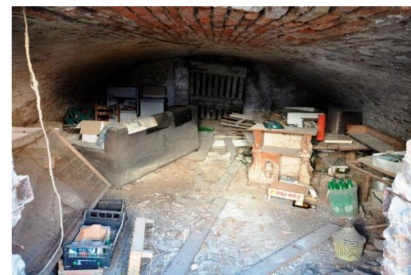
Foto 8 e 9 – foto 8, il seminterrato con volta a botte ribassata; foto 9 – sottotetto, l'ultima rampa presenta un andamento ripido e rigirante in quanto l'arrivo è "anticipato" rispetto al pianerottolo sottostante (la finestrella che si vede nella foto è quella che si affaccia su via XX Settembre). (foto C. Lazzari)
