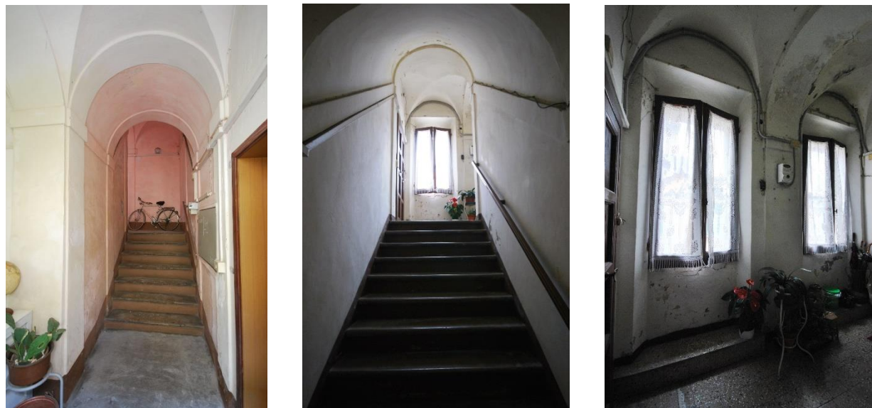
Foto 3, 4 e 5 – foto 3, la prima rampa (si noti la partenza degli scalini arretrata rispetto all'ingresso); foto 4 – la seconda rampa; foto 5 – il pianerottolo del piano primo con le due finestre. I vani delle rampe sono coperti con volta a botte mentre i pianerottoli con due crociere (foto 6 e 7). (foto C. Lazzari)
