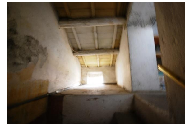
Foto 8 e 9 – foto 8, il seminterrato con volta a botte ribassata; foto 9 – sottotetto, l'ultima rampa presenta un andamento ripido e rigirante in quanto l'arrivo è "anticipato" rispetto al pianerottolo sottostante (la finestrella che si vede nella foto è quella che si affaccia su via XX Settembre). (foto C. Lazzari)
