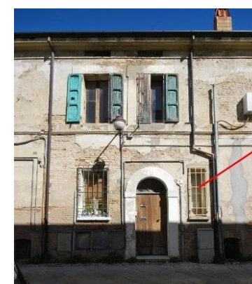
Foto 85 e 86 – Corpi ed elementi estranei nelle Unità n.13 e n.14 (Case dei salinari). Nella foto a sx sono segnalati: il corpo edilizio che sovrasta il muro storico del cortile e lo spazio pubblicitario non consoni ai caratteri dell'edificato storico. Nella foto a dx una finestrella incongrua per forma e posizione rispetto alla composizione ritmica della facciata settecentesca ed un piccolo corpo tecnico (cassetta impianti) applicato nella facciata.
