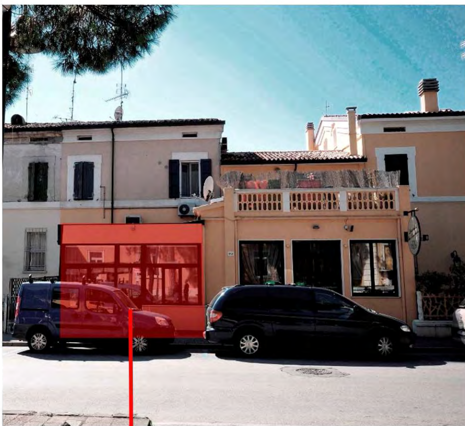
Corpo edilizio estraneo all'organismo edilizio da demolire
