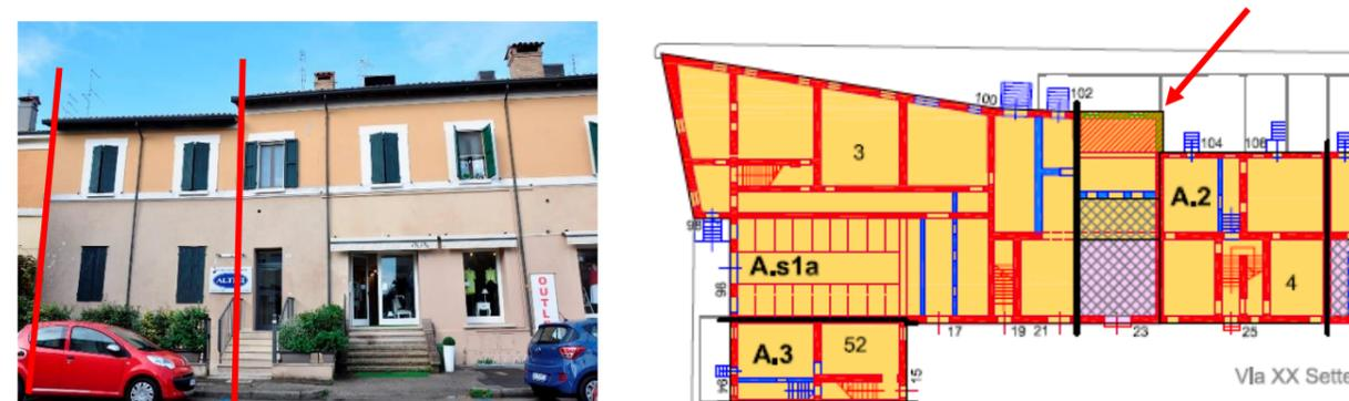
Foto 75 e stralcio tav. CS.2a (Unità n. 3 e 4) – E' evidenziato l'incremento, nell'Unità tipologica n.4 (Casa dei Salinari), di una nuova cellula allineata alle strutture del Baluardo. Il prospetto su strada dell'ampliamento si integra all'adiacente di primo impianto utilizzando i medesimi elementi (cornici, marcadavanzale, ecc.), solo la linea di gronda risulta di altezza inferiore quasi a voler segnalare la diacronicità dell'intervento.
