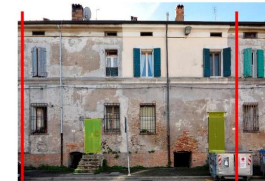
Foto 10 e 11 - prospetto interno ed esterno dell'unità tipologica n.43 (via XX Settembre n. 197), il fronte interno si presenta integro, in quello esterno sono state aperte due porte (in giallo) al fine di disimpegnare i diversi alloggi. In origine il fronte esterno fungeva da mura urbane ed era pertanto privo di accessi diretti. (foto A. Vallicelli)
