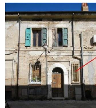
Foto 85 e 86 – Corpi ed elementi estranei nelle Unità n.13 e n.14 (Case dei salinari). Nella foto a sx sono segnalati: il corpo edilizio che sovrasta il muro storico del cortile e lo spazio pubblicitario non consono ai caratteri dell'edificato storico. Nella foto a dx una finestrella incongrua per forma e posizione rispetto alla composizione ritmica della facciata settecentesca ed un piccolo corpo tecnico (cassetta impianti) applicato nella facciata.
