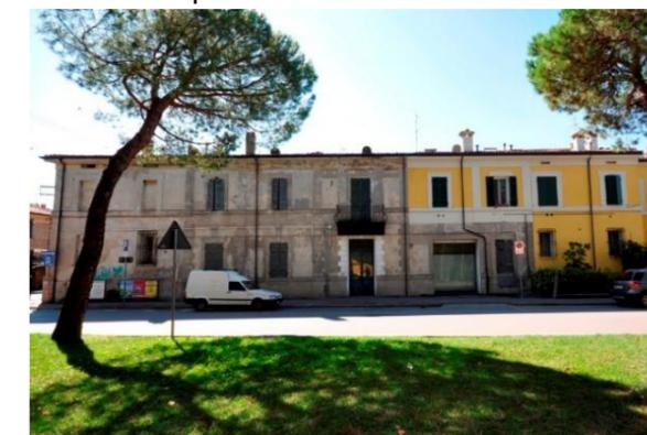
Foto 27 e 28 – L'inserimento del "Dopolavoro salina" ha solo in parte modificato l'assetto interno ed il prospetto con l'inserimento del balconcino con sottostante porta d'ingresso, incongrua risulta l'adiacente apertura carrabile. Le cellule relative al "teatro delle commedie" (fronte interno) sono state trasformate in abitazione. (foto A. Vallicelli)
