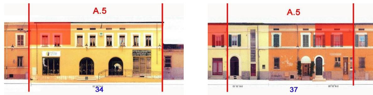
38 - L'unità n. 34 presenta una scansione ritmica delle finestre completamente diversa dal tipo originario, le aperture dell'unità 37 risultano parzialmente alterate con particolare riferimento al "taglio" verticale sul fronte che rivela una nuova scala interna, si conservano comunque alcuni elementi tipici (il medesimo allineamento delle fronti, il marca davanzale, le cornici alle finestre, ecc.)
