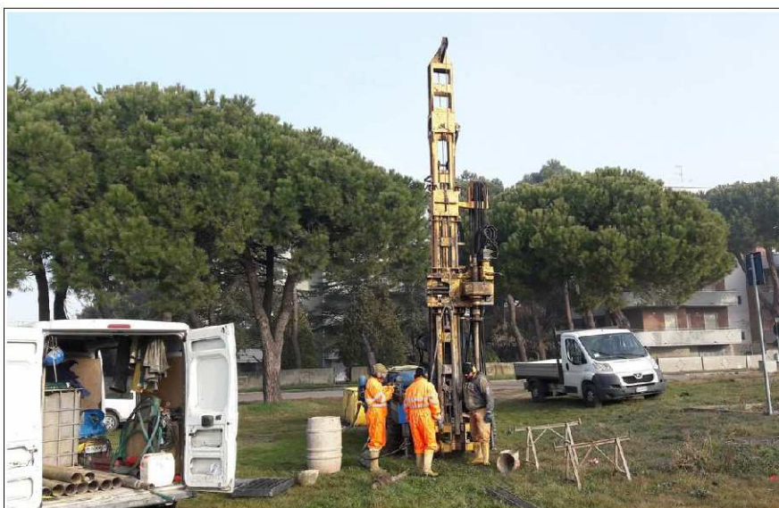
Foto 4.1 - Esecuzione del sondaggio a Pinarella di Cervia
