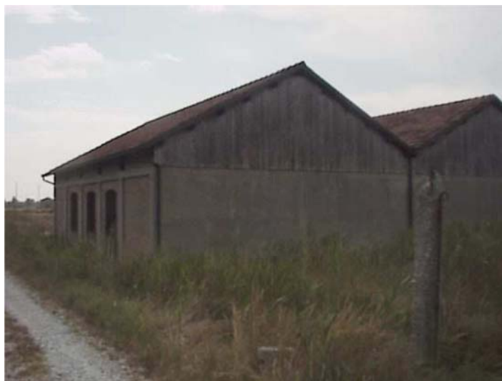
Figura 8: Vista del retro della struttura
