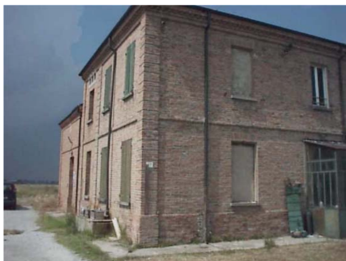
Figura 15: Particolare dell'edificio con funzioni d'idrovora
