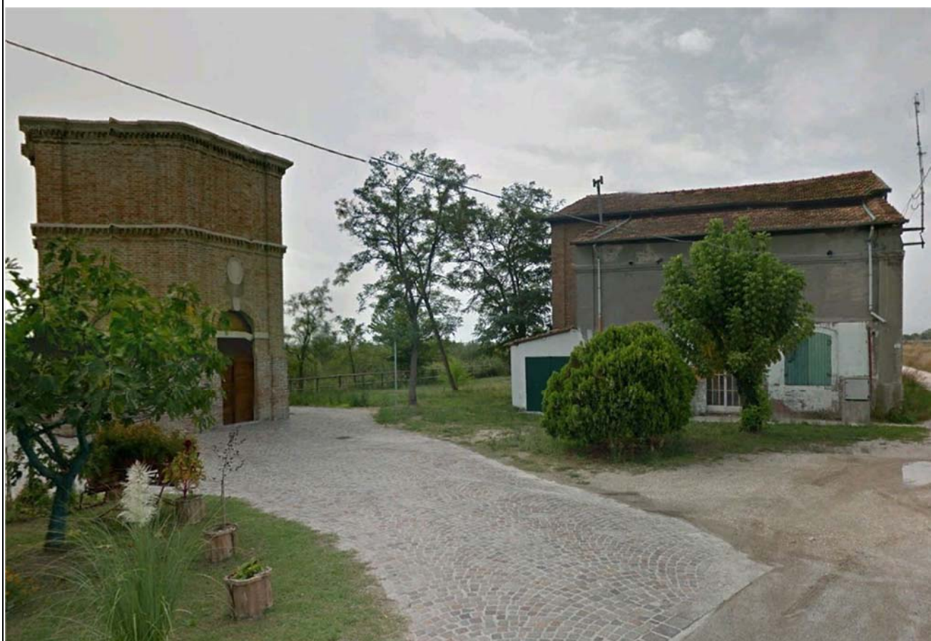
Figura 1: Panoramica sull'idrovora di via Bova e la torre esagonale presente
