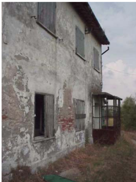
Figura 7: Particolare di uno dei lati del edificio
