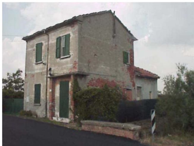
Figura 12: Casello Cesena visto dalla SS Cervara in direzione ovest
