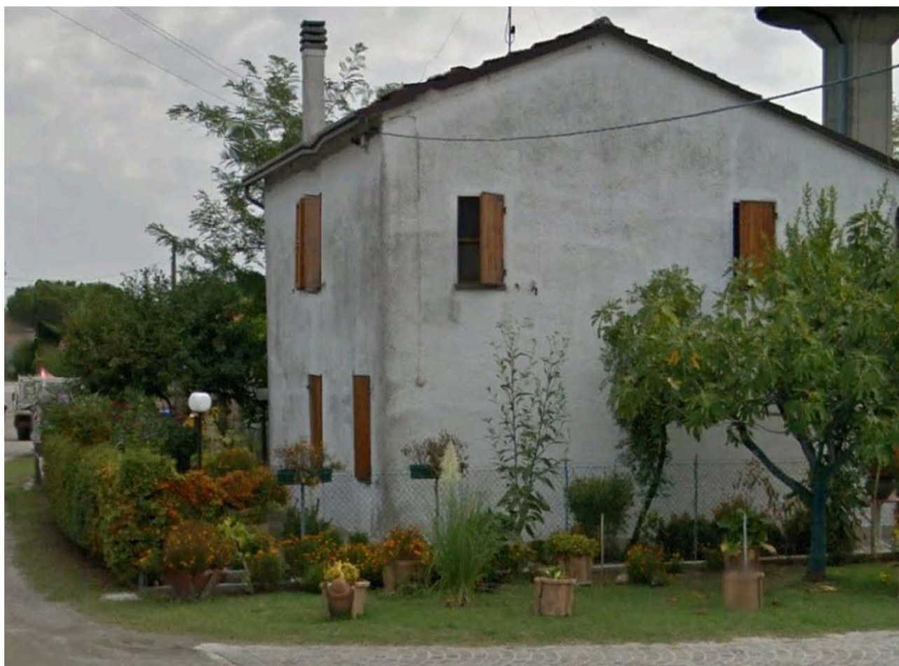
Figura 4: Vista del retro dell'edificio
