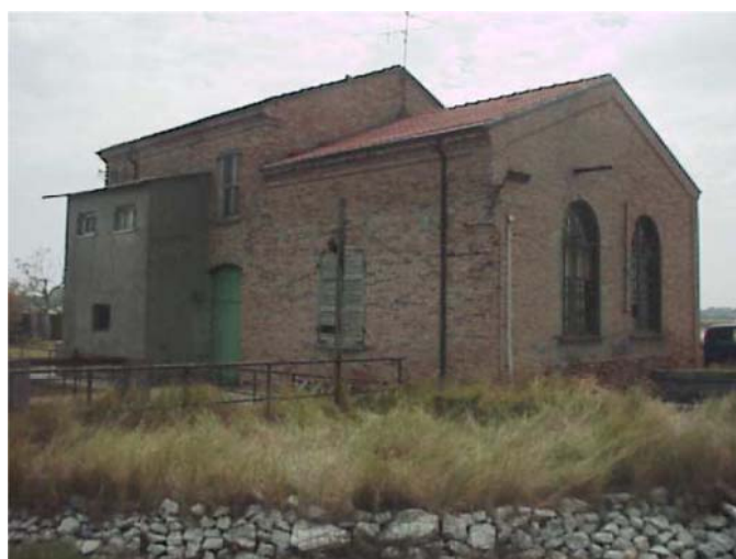
Figura 14: Vista generale dell'immobile
