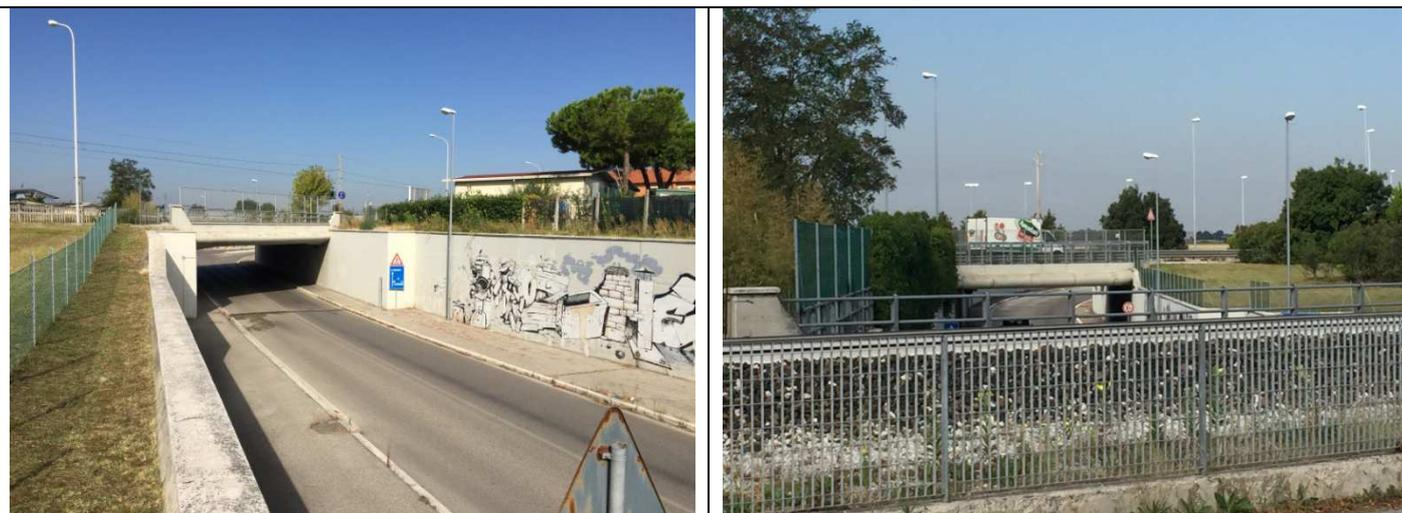
Il sottopasso ricade in area allagabile delle mappe del CBR ed esondabile nelle mappe del QC del PTCP Ravenna. Non sono presenti sistemi di allertamento e/o limitazioni del traffico in caso di eventi alluvionali. **CLASSE 1 - RISCHIO ELEVATO**
