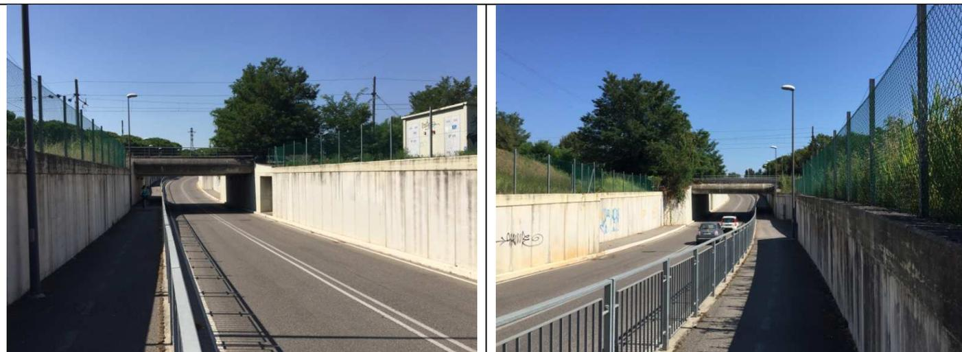
Il sottopasso ricade in area allagabile delle mappe del CBR e in zona con tirante idrico di riferimento da 50 a 150 cm nelle mappe del PAI 2016. Non sono presenti sistemi di allertamento e/o limitazioni del traffico in caso di eventi alluvionali. **CLASSE 2 - RISCHIO MOLTO ELEVATO**
