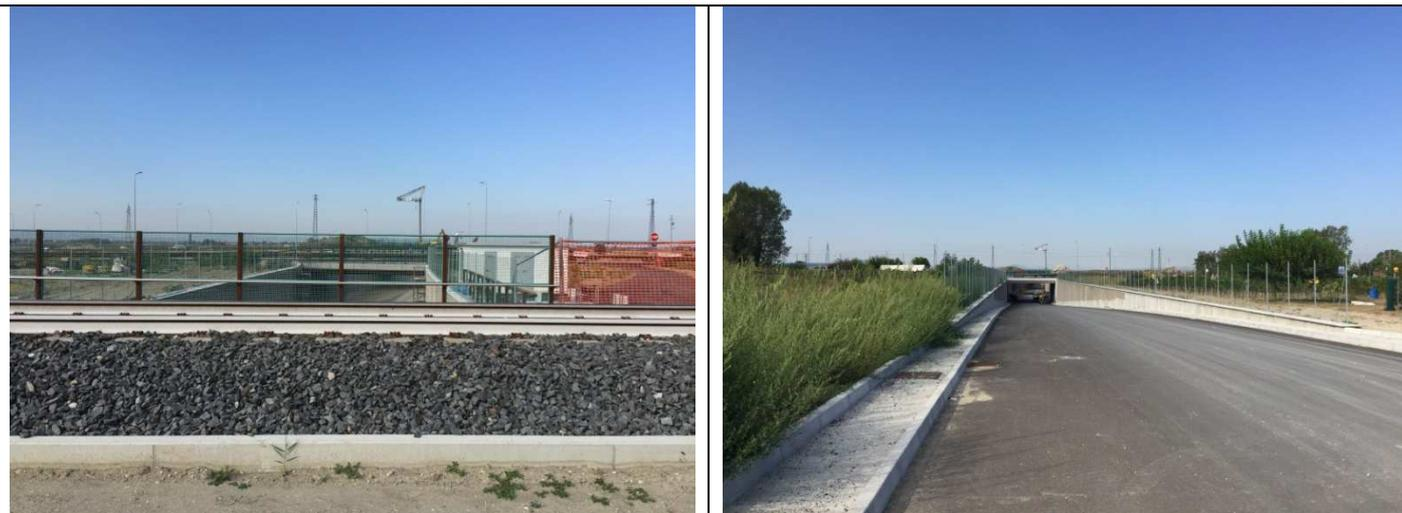
Il sottopasso ricade in area con tirante idrico di riferimento da 50 a 150 cm nelle mappe del PAI 2016, in area allagabile nelle mappe del CBR e in area esondabile del QC del PTCP Ravenna. Attualmente in costruzione. **CLASSE 3 - RISCHIO MOLTO ELEVATO**
