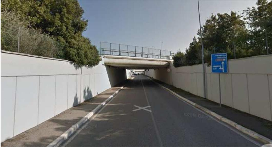
Sottopasso ricadente in area allagabile nelle mappe del CBR, nelle mappe del QC del PTCP Ravenna e con tirante idrico di riferimento oltre 150 cm nel PAI 2016. Non sono presenti sistemi di allertamento e limitazioni all'accesso in caso di evento alluvionale. Il sottopasso è collegato al n.2 nello stesso svincolo sulla SS16. **CLASSE 4 - RISCHIO MOLTO ELEVATO**
