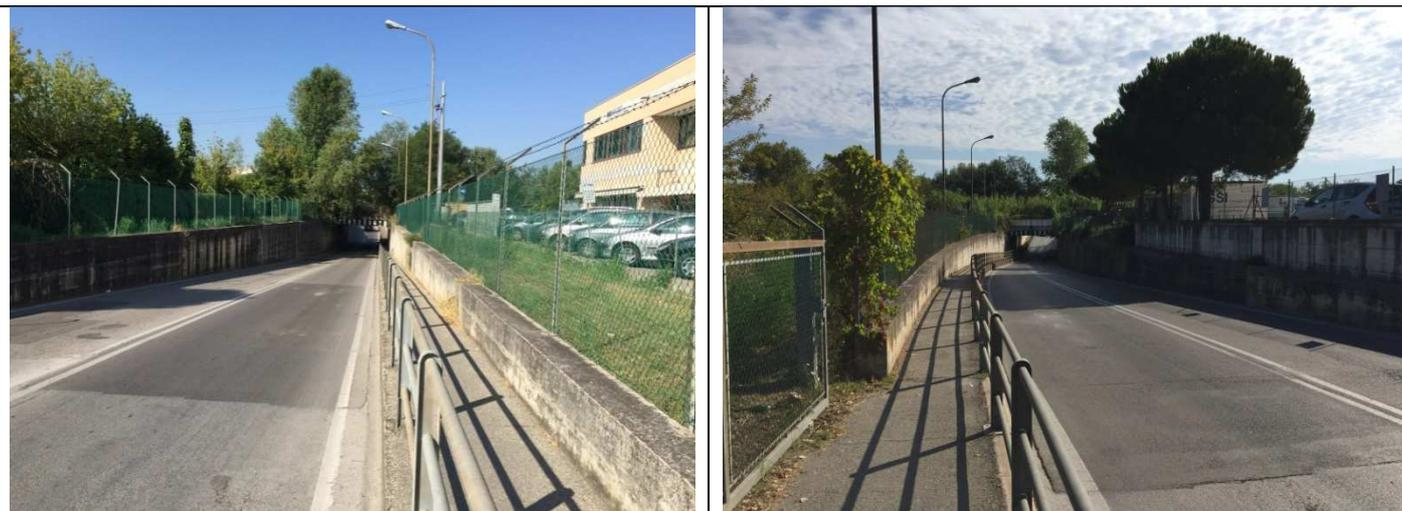
Il sottopasso ricade in area con tirante idrico di riferimento da 50 a 150 cm nelle mappe del PAI 2016. Sono presenti sistemi di allertamento e limitazioni del traffico in caso di eventi alluvionali (semaforo). **CLASSE 7 - RISCHIO ELEVATO**
