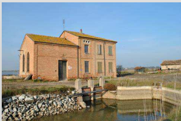
Casello Vallone con idrovora
