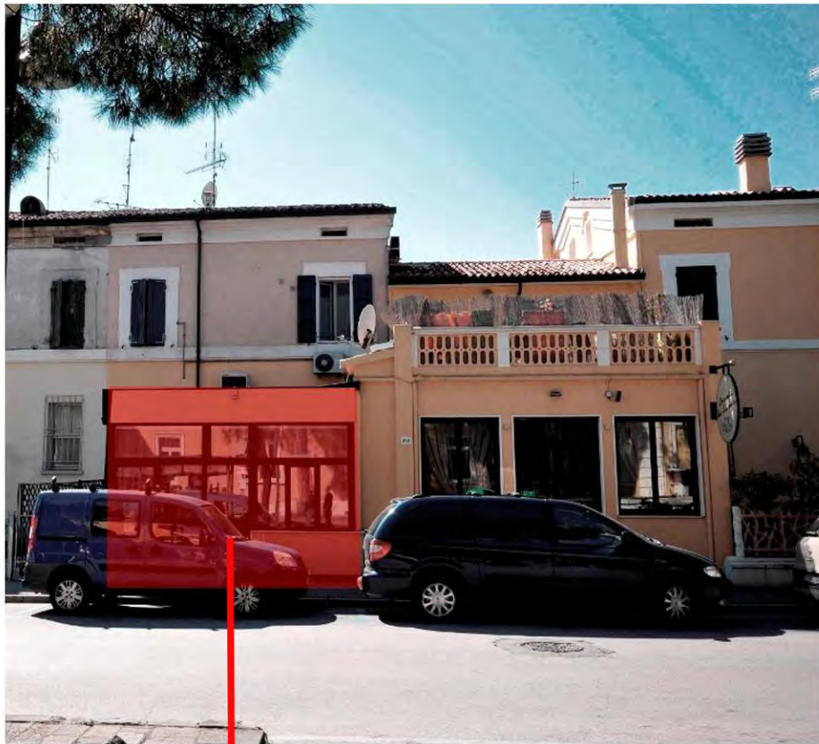
Corpo edilizio estraneo all'organismo edilizio da demolire
