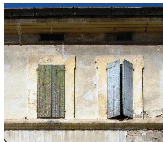
Foto 14 e 15 – le cornici sagomate alle finestre del piano primo ed il cornicione in elementi modulari con la fascia di raccordo al muro ove sono inserite le finestrelle di sottotetto (foto A. Vallicelli)
