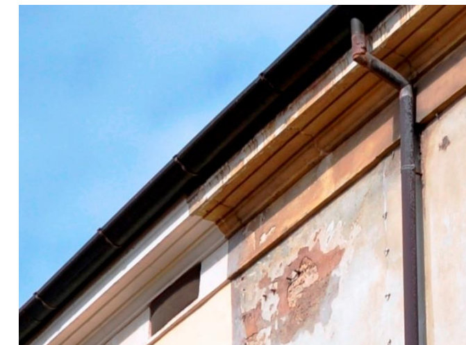
Foto 14 e 15 – le cornici sagomate alle finestre del piano primo ed il cornicione in elementi modulari con la fascia di raccordo al muro ove sono inserite le finestrelle di sottotetto (foto A. Vallicelli)
