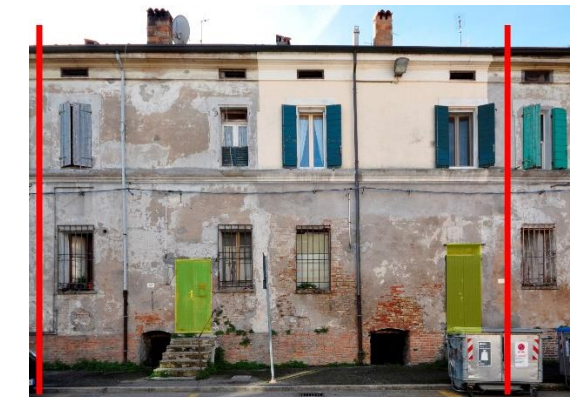
Foto 10 e 11 - prospetto interno ed esterno dell'unità tipologica n.43 (via XX Settembre n. 197), il fronte interno si presenta integro, in quello esterno sono state aperte due porte (in giallo) al fine di disimpegnare i diversi alloggi. In origine il fronte esterno fungeva da mura urbane ed era pertanto privo di accessi diretti. (foto A. Vallicelli)
