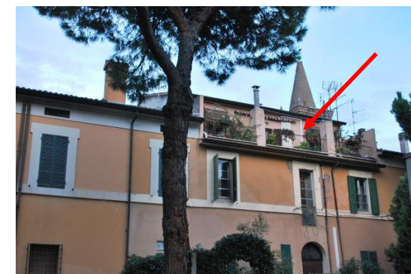
Foto 81 e 82 – Incrementi verticali fuori sagoma delle Unità n. 32 e n. 37 (Case dei salinari). Nella foto a sx la cellula del cortile, in origine ad un piano, è stata sopraelevata di due piani di cui l'ultimo con un corpo dotato di loggia; nella foto a dx la sopraelevazione riguarda parte delle cellule originarie a due piani ed ha comportato anche la modifica della falda di copertura.
