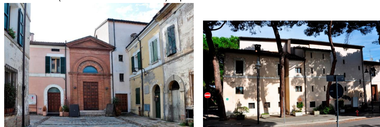
Foto 40 e 41 – L’ingresso del teatro nella strada interna (via XX Settembre) in muratura a faccia a vista e la cortina muraria compatta del fronte esterno in via della Stazione. (foto A. Vallicelli)
