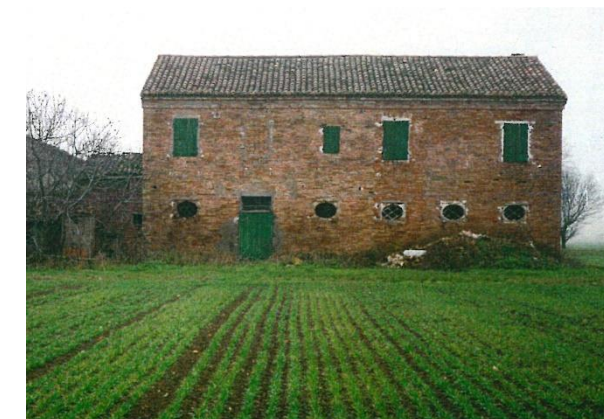
Foto 106 e 107 – Casa colonica dell'area centuriata (via del Confine). A sx il fronte con il portico parzialmente tamponato per ricavare servizi e le finestre del piano primo "tagliate" dalla falda di copertura del portico; a dx il retro del medesimo edificio dove si "legge" al piano terra la porta della stalla con le finestrelle ovali di areazione, al piano primo la piccola finestra segnala l'arrivo della scala interna perpendicolare al fronte.
