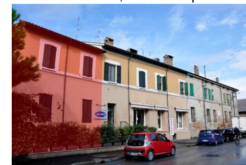
Foto 23 e 24 Baluardo riutilizzato a residenza al piano primo. A seguito di un ampliamento dell'adiacente casa (in rosso) ne è stata "estesa" la lunghezza del fronte est. Sempre sullo stesso
