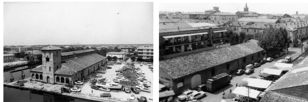
Foto 36 e 37 – Il magazzino del sale alla darsena ed il magazzino (tipo A.s5) dove si conservavano i materiali da costruzione della “Nuova Città”, poi magazzino del sale di riserva (foto del 1975 di F. Valbonesi).
