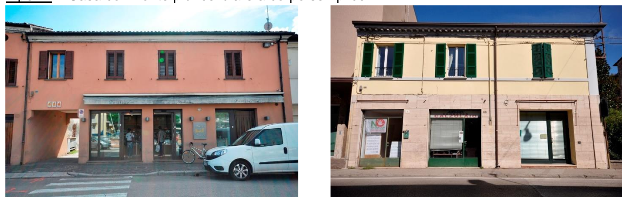
Foto 63 e 64 - Edifici con fronte pluricellulare a corpo semplice in Borgo Marina (foto A. Vallicelli)
