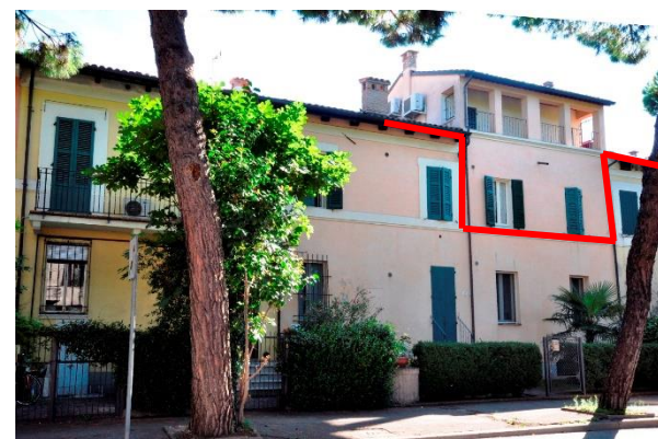
Foto 81 e 82 – Incrementi verticali fuori sagoma delle Unità n. 32 e n. 37 (Case dei salinari). Nella foto a sx la cellula del cortile, in origine ad un piano, è stata sopraelevata di due piani di cui l'ultimo con un corpo dotato di loggia; nella foto a dx la sopraelevazione riguarda parte delle cellule originarie a due piani ed ha comportato anche la modifica della falda di copertura.
