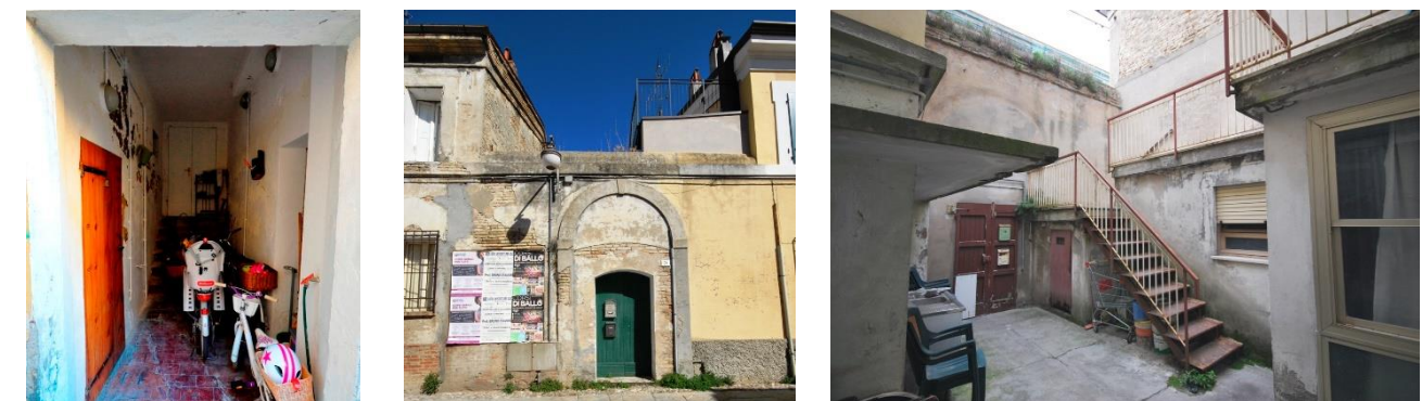
Foto 16, 17 e 18 – La scala che dal cortile conduce direttamente al primo pianerottolo della scala principale. La porta d'accesso al cortile con la cornice in rilievo che inquadra un'ampia apertura e l'interno di un cortile in parte intasato da corpi aggiunti. (foto A. Vallicelli e C. Lazzari)
