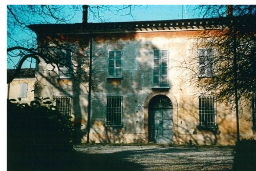
Foto 101 e 102 – a sx casa Pignata in via Sirena a Cervia, casa colonica bicellulare con portico tamponato; a dx villa Ricci in via Naviglio a Castiglione, villa rurale con impianto progettato.
