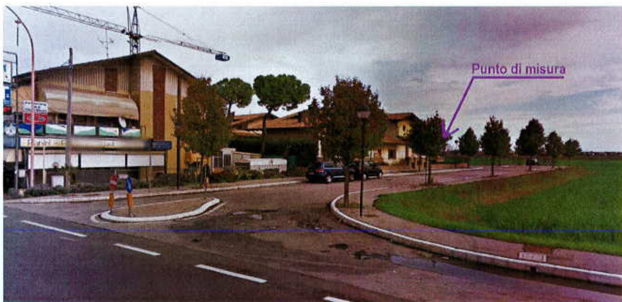
Fotografia con indicazione punto di misura. Si nota sulla sinistra fronte edificato su Via Bollana e intersezione esistente sulla stessa strada.
