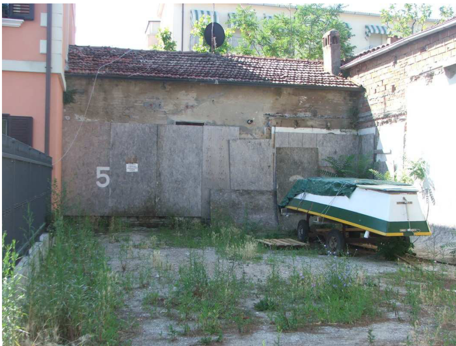
Figura 6 – Stato attuale lato Nord
