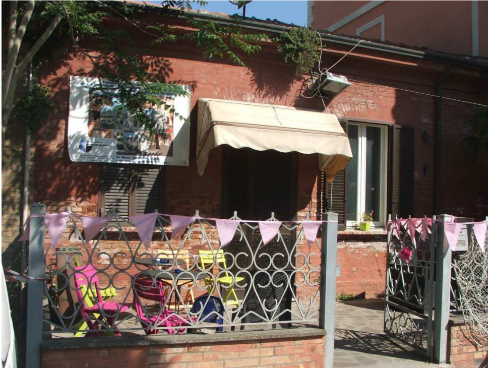
Figura 5 – Stato attuale lato Sud
